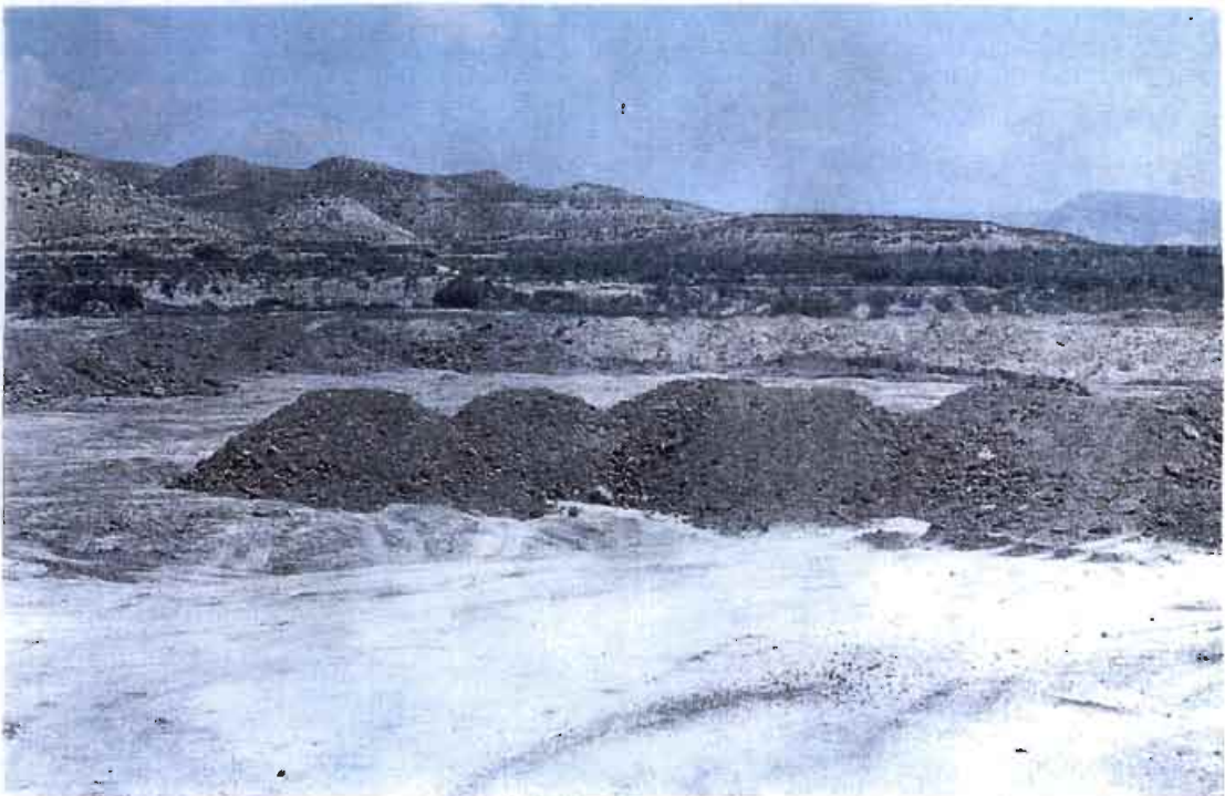
E.8 y E.9 Separación de suelo vegetal
