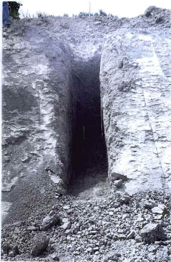
E.7 Zanja para la ubicación de las tuberías de descarga de ARU
