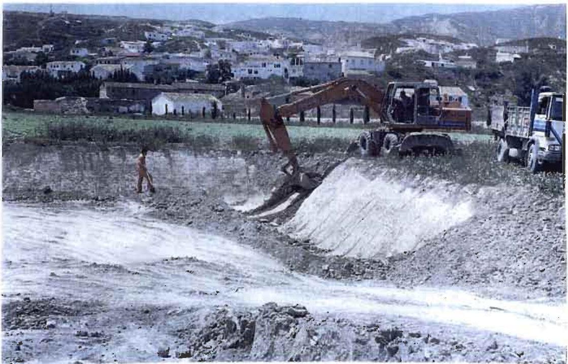
E.4 Excavación de los taludes de las balsas
