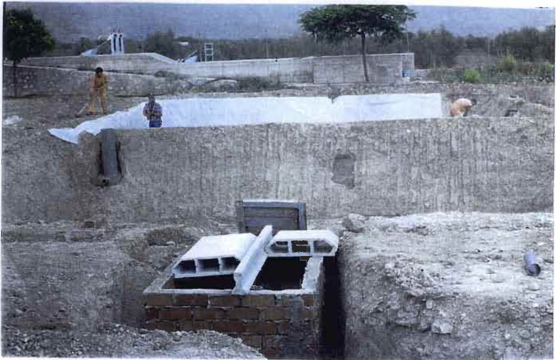
D.13 Arqueta de control y vaciado de la balsa de decantación. Al fondo perspectiva de la planta de tratamiento primario, balsa almacén impermeabilizándose y balsa de decantación
