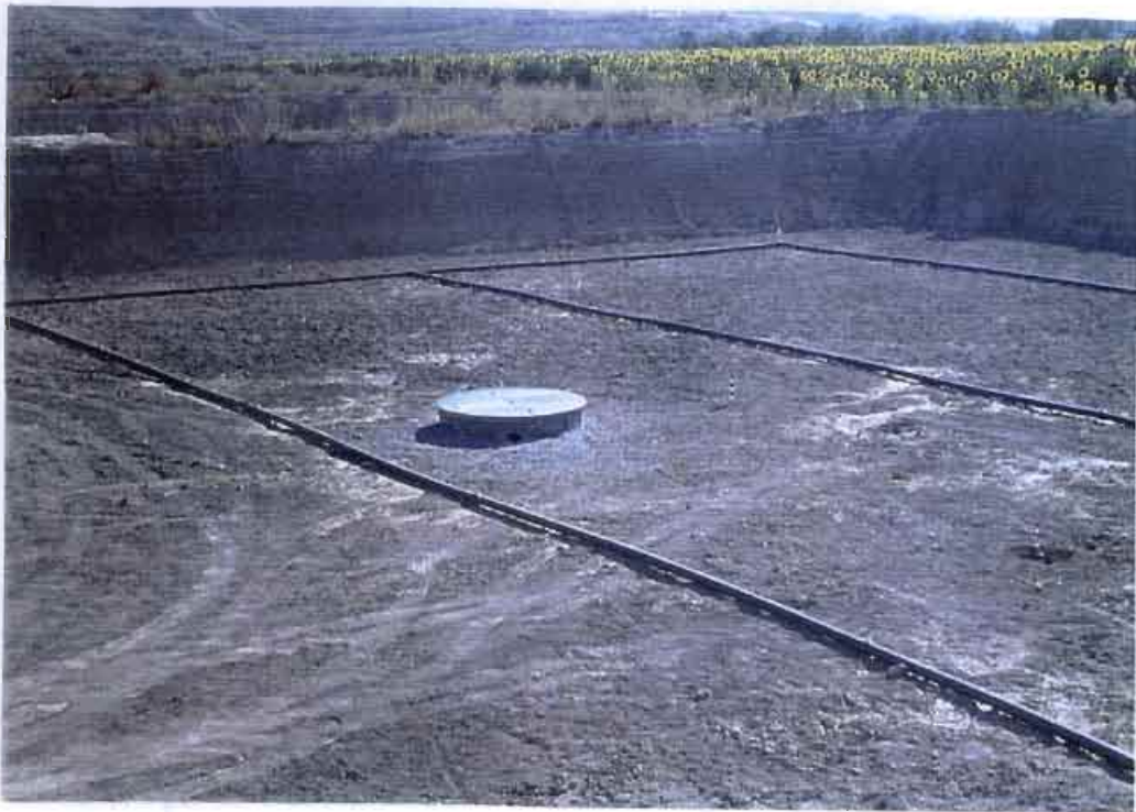
E.14 Balsa de infiltración "A"
