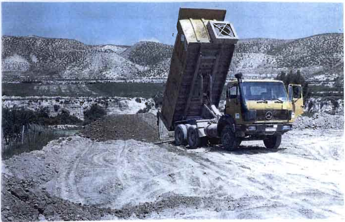
E.8 y E.9 Separación de suelo vegetal
