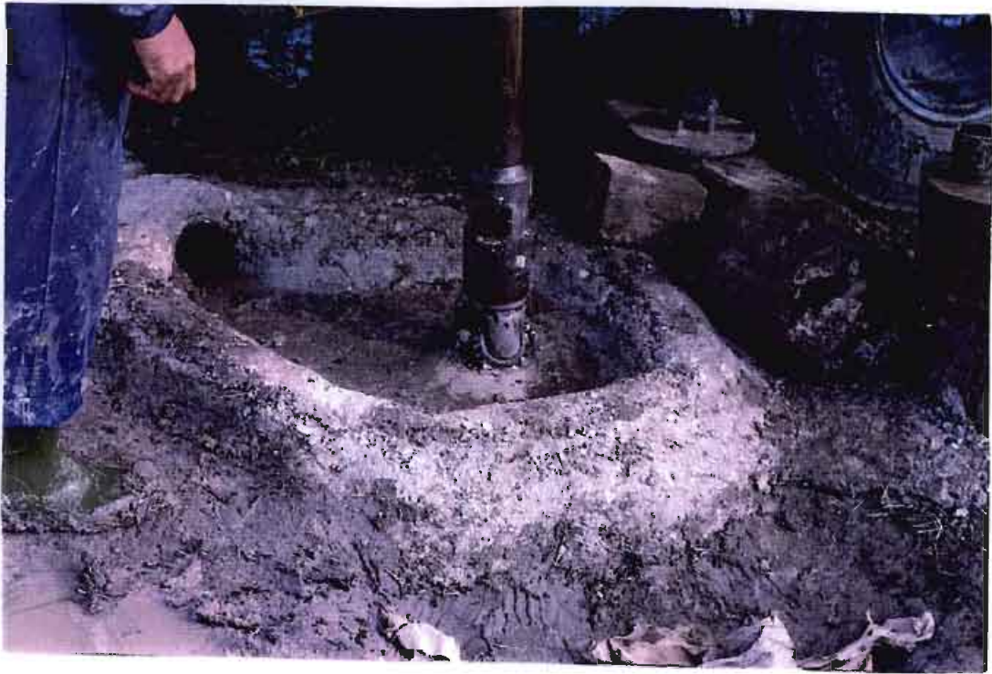
B.3 Inicio de perforación con tricono 4 1/2"
