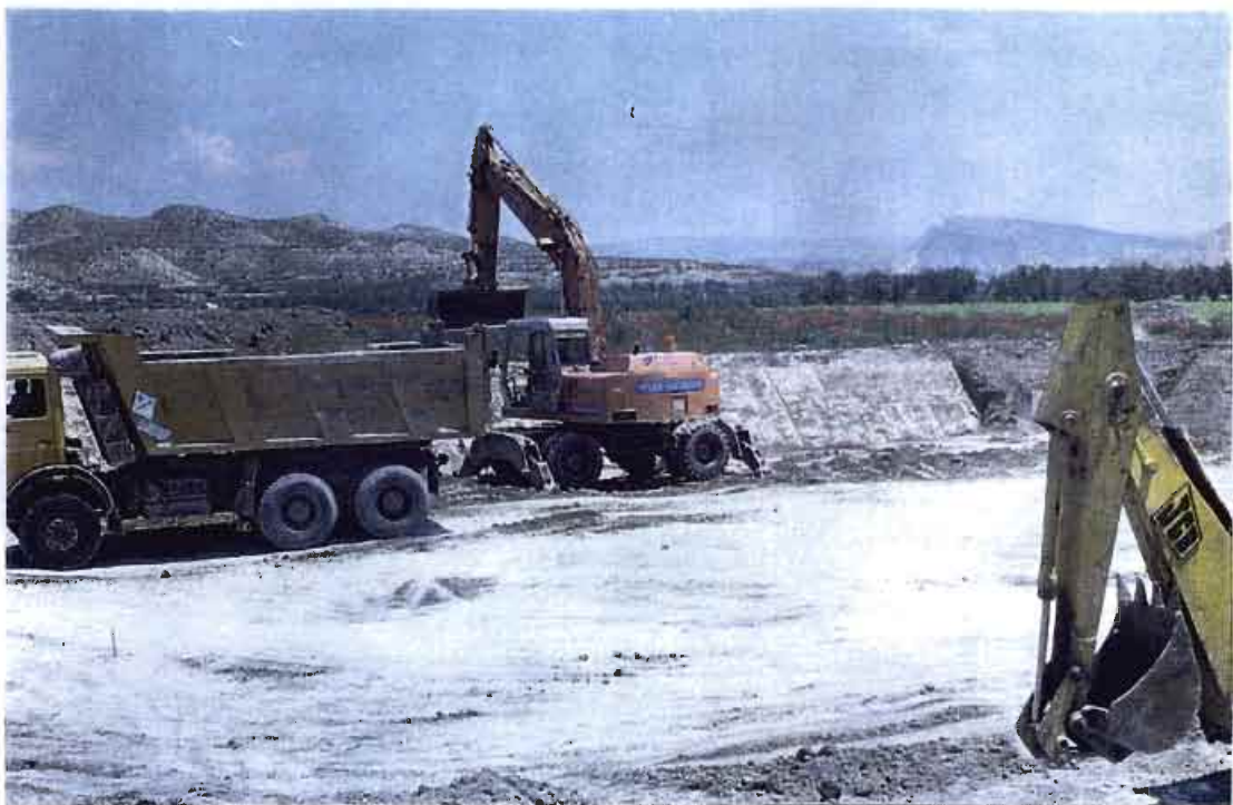
E.2 Excavación de las balsas
