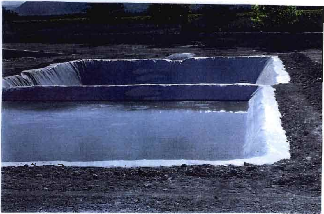
D.19 Balsa almacén vacía de ARU y balsa de decantación llena de ARU
