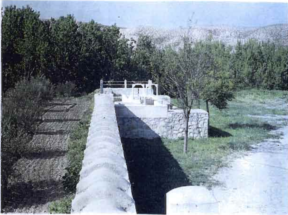
C.1 Colector unitario de agua residual urbana (ARU)
