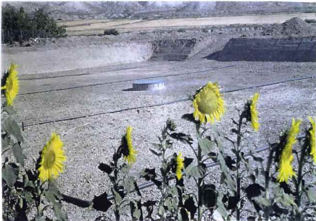
E.15 Balsa de infiltración "B"
