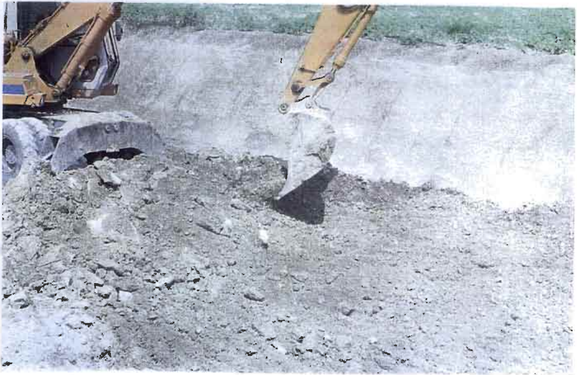
E.3 Excavación de las balsas
