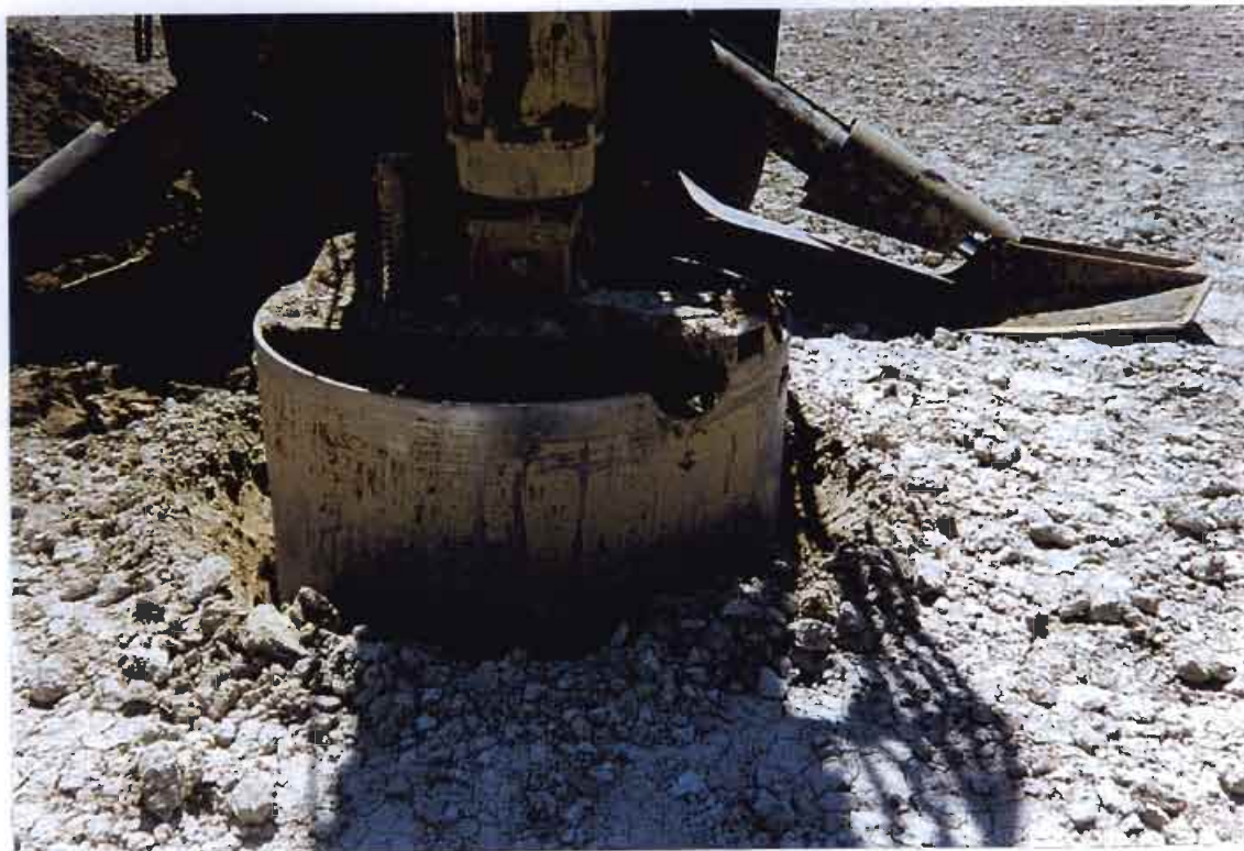
F.1 Inicio de la perforación de los pozos en el centro de las balsas de infiltración
