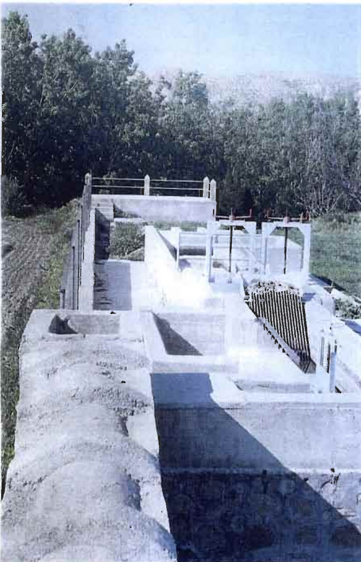
C.1 Colector unitario de agua residual urbana (ARU)
