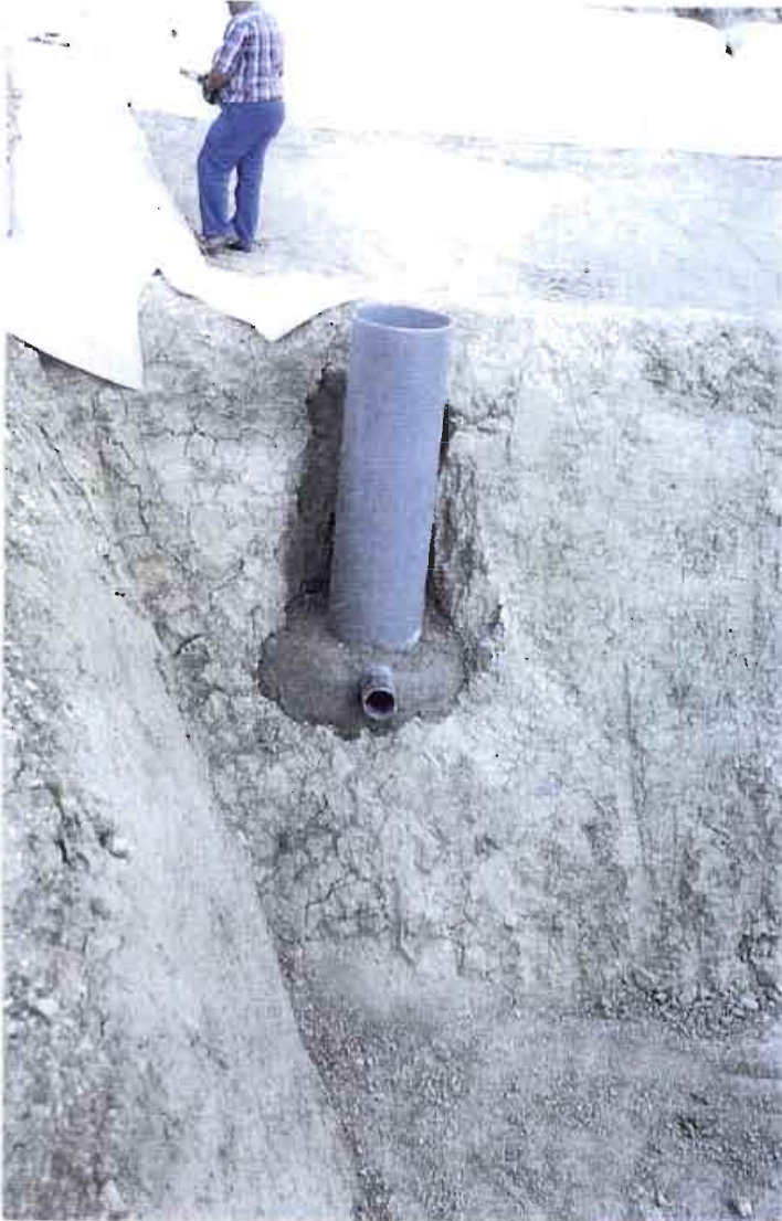
D.11 Zanjas para la ubicación de tuberías de desagüe y rebosadero de balsa de decantación
