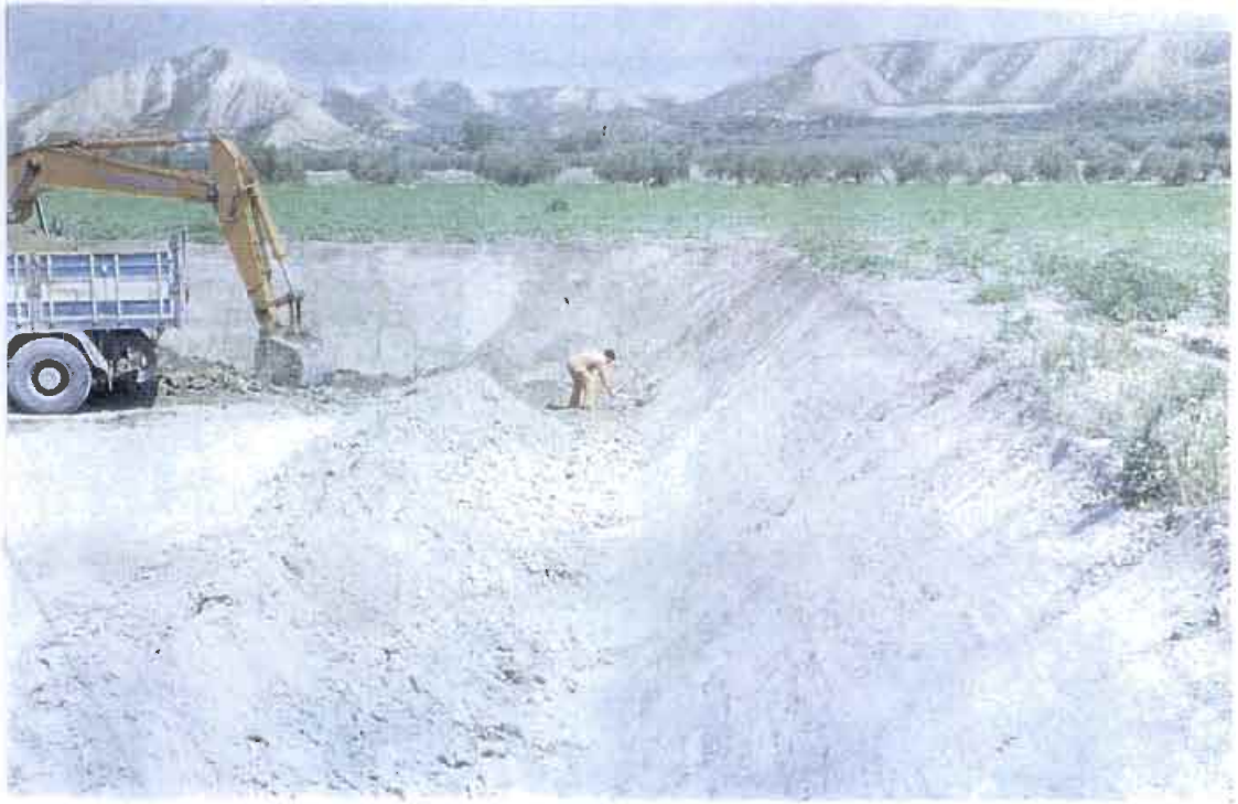
E.10 y E.11 Nivelación del fondo de las balsas
