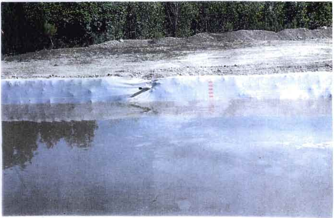
D.7 Balsa almacén llena de ARJ. Detalle del rebosadero
