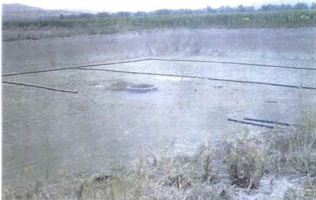
E.13 Montaje de las tuberías de descarga de ARU
