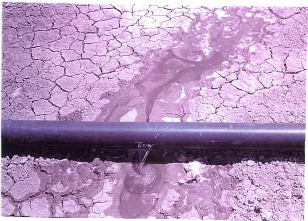
E.16 Tubería ranurada de descarga de ARU
