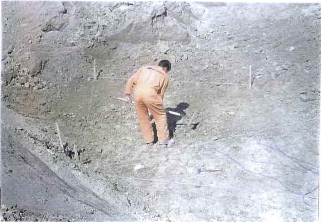
E.10 y E.11 Nivelación del fondo de las balsas
