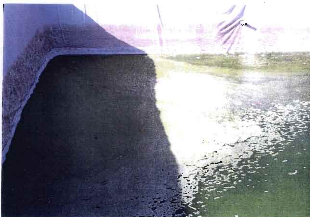
D.16 Balsa de decantación. Detalle de formación de algas
