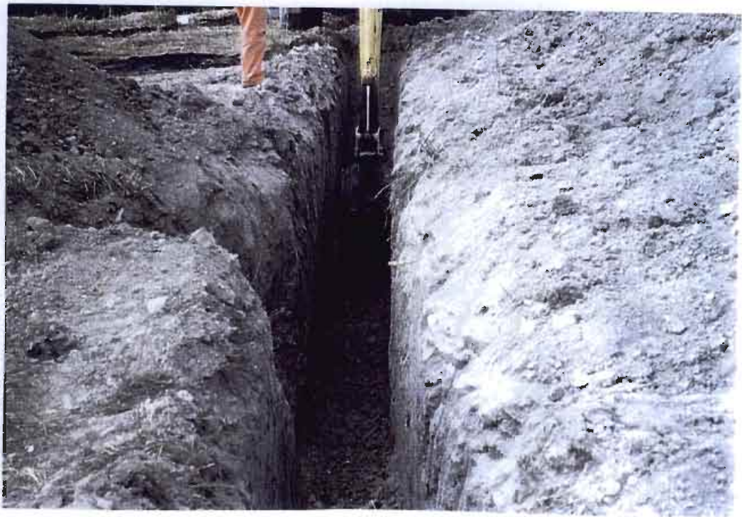
D.11 Zanjas para la ubicación de tuberías de desagüe y rebosadero de balsa de decantación
