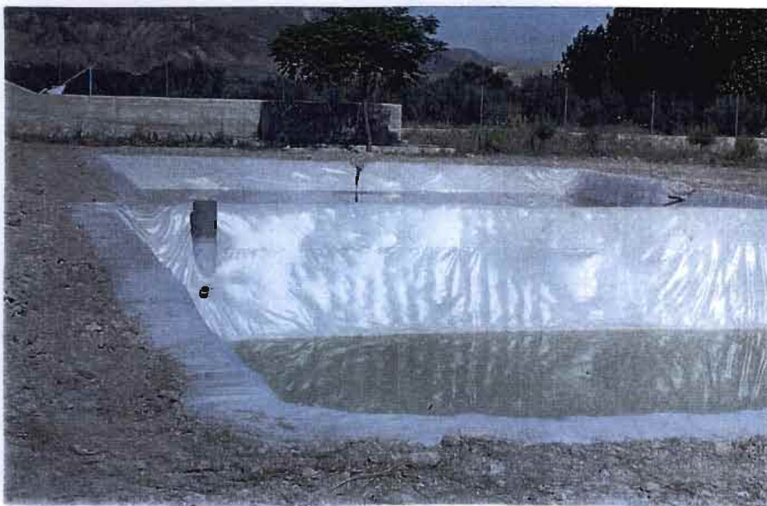
D.17 Balsa almacén llena de ARU y balsa de decantación vacía
