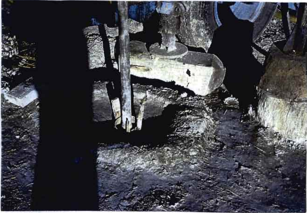
B.5 Cementación del entubado del sondeo de control S-2
